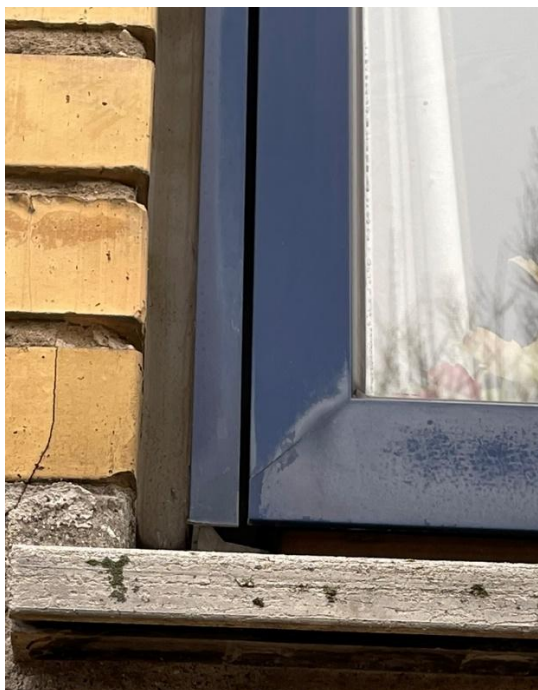
13. Elastiske fuger omkring vinduer og døre.
