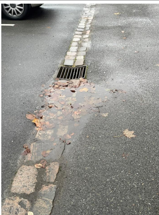
26.2 Lunker med vandpytter oprettes med slidlags asfalt når man synes de er for store.
