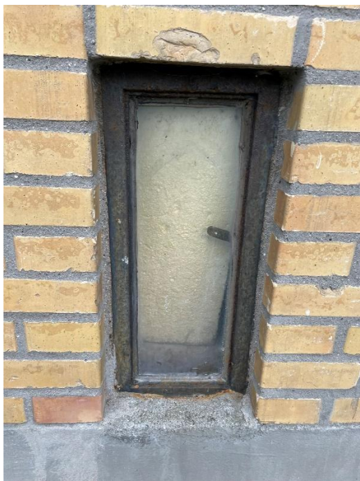
12. Små kældervinduer med stålrammer ved pulterrummene.
